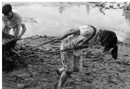
010 Construction de la piscine de l'Université de Pékin par les étudiants, juin 1958. © Fondation Henri Cartier-Bresson / Magnum Photos
