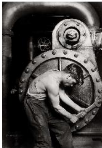
Mécanicien à la pompe à vapeur dans une centrale électrique, 1920
